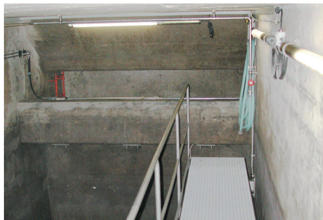
STEP Zurich-Wollishofen, moitié gauche du bassin, dégrilleur RSU - ROMAG en arrière plan. La conduite hydraulique pour le cylindre est bien visible. Le cylindre hydraulique est légèrement visible au-dessus de la bordure du mur.
