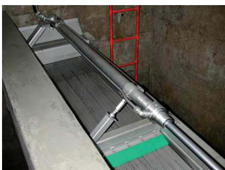
Dégrilleur RSU ROMAG. Côté délestage avec cylindre hydraulique et chariot de nettoyage. Le socle en béton représente le délestage d'urgence.
