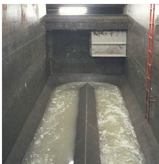
STEP Zurich-Wollishofen, moitié droite du bassin avec fosse de produit filtré en arrière plan. Le dégrilleur RSU de ROMAG est monté derrière le socle en béton.
