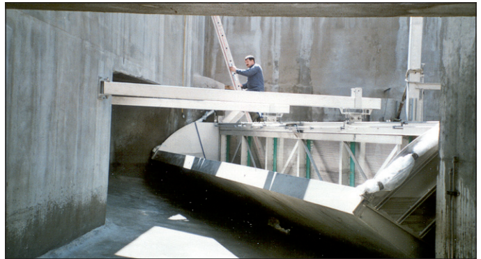
STEP Telli à Aarau, ROMAG Dégrilleur RSW-K 14x8/4 (phase de montage)
