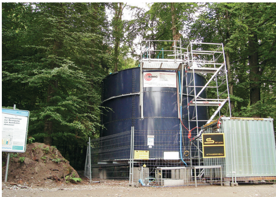
Installation complète avec le container de mesure (à droite)
