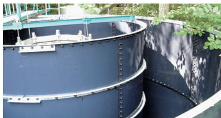
A l'extérieur, le bassin de décantation pour le first-flush. Dans le cylindre bleu foncé, le bassin de décantation pour le second-flush et le filtre d'écoulement.
