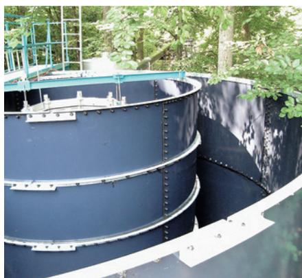
Aussen das Absetzbecken für den First-flush. Im dunkelblauen Zylinder das Absetzbecken für den Second-flush und der Abflussfilter.
