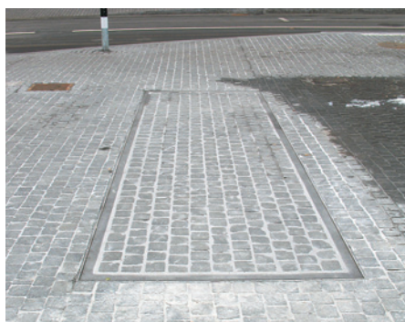
Limmatquai Zurich: la trappe de fosse est entièrement intégrée dans le revêtement de la rue.
