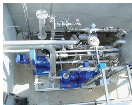
Groupe des pompes avec alimentation en ozone (droite) dans le réacteur.
