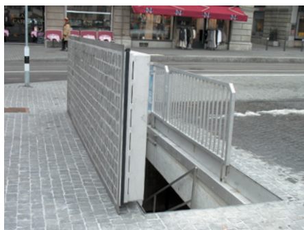
Les barrières rabattables sont aussi mises en place et déployées par le système hydraulique.
