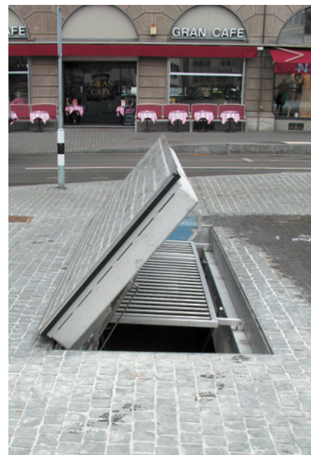
L'actionnement d'un simple bouton permet au système hydraulique de lever la trappe de plusieurs tonnes.
