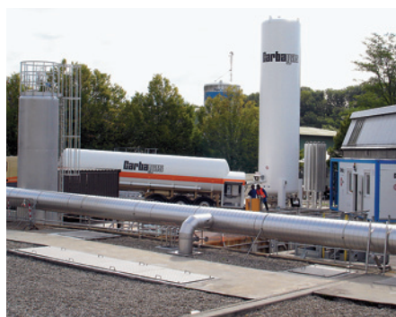
A gauche, la moitié supérieure du réacteur d'ozonisation qui se trouve dans le puits de pompage. Au milieu, l'alimentation en oxygène. A droite, le conteneur avec le générateur d'ozone et la commande, ainsi que la surveillance de toute l'installation.
