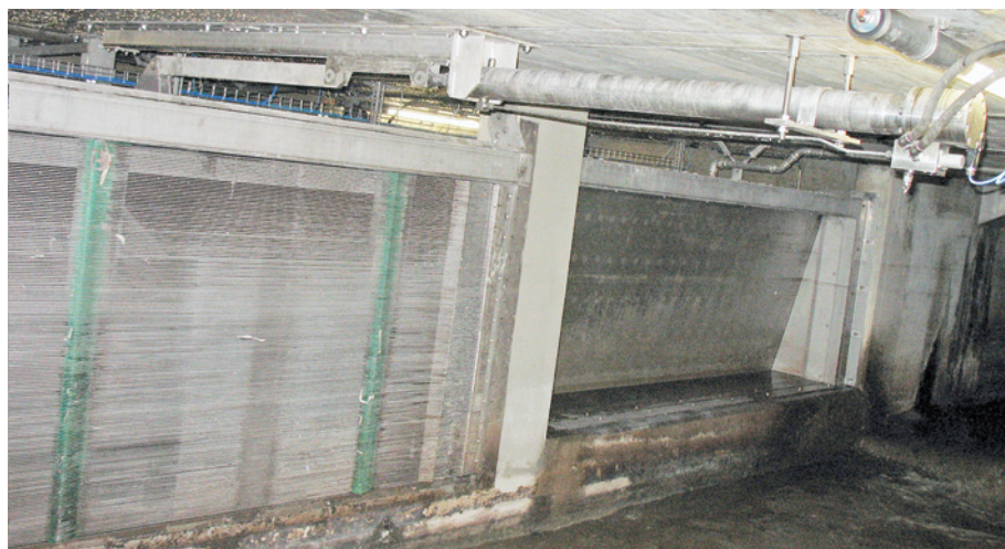
Vue partielle du dégrilleur à grand débit RSW-K (à gauche); l'une des deux vannes pour la décharge de secours (à droite).
