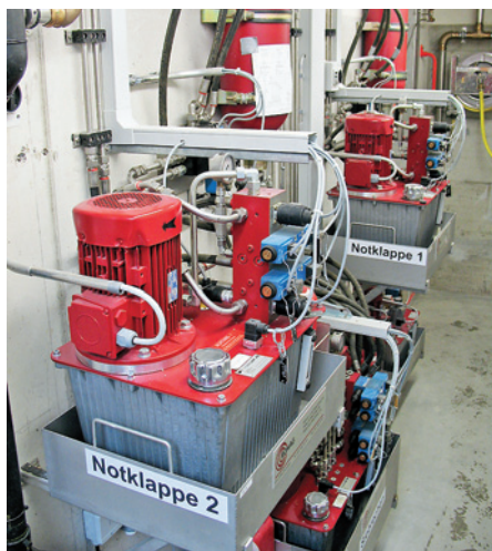
Commandes hydrauliques pour le dégrilleur (en bas) et les deux vannes de décharge.
