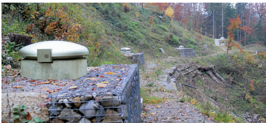
Cinq captages d'eau à Rüti / ZH avec couvercles sécurisés AQUASAFE ROMAG.
