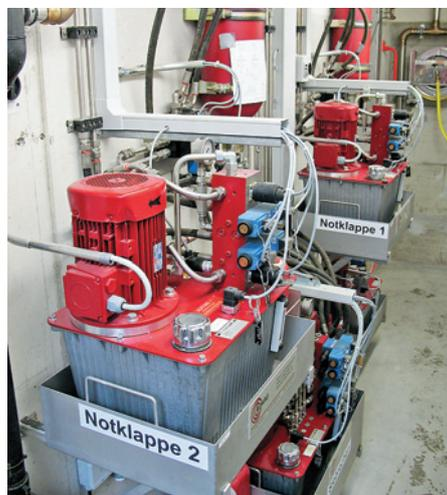
Hydraulikantriebe für den Siebreechen (unten) und die beiden Notentlastungsklappen.
