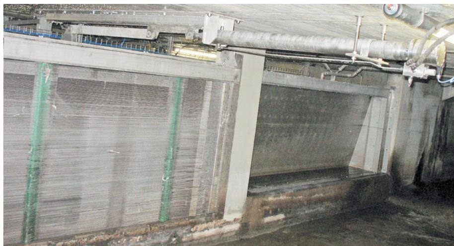
Teilansicht des Siebreechens RSW-K (links); eine der zwei Notentlastungsklappen (rechts).
