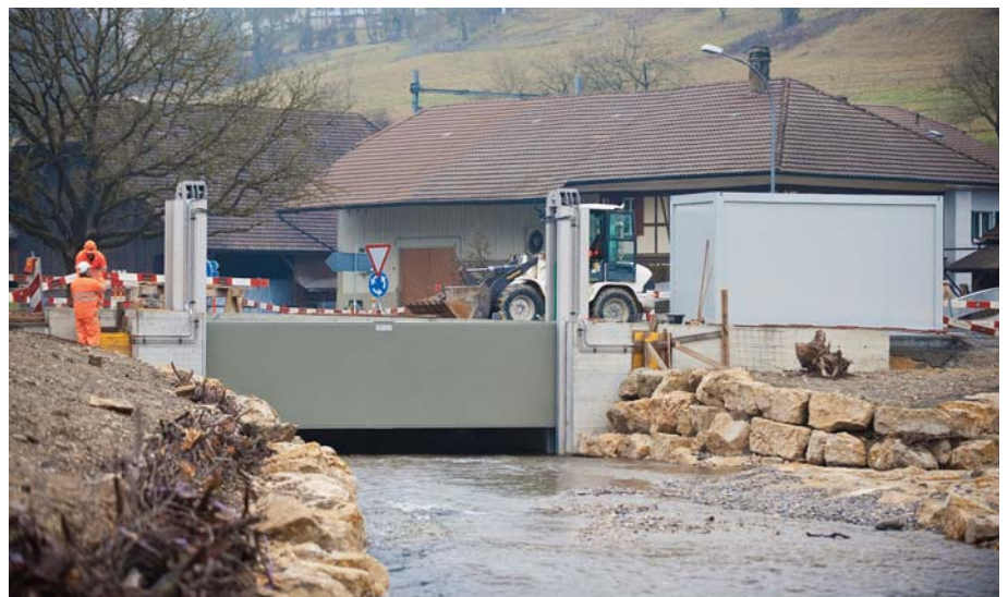
Drosselschieber in Stellung «Hochwasser». Rechts davon der Container mit Steuerung, Fernüberwachung, Antrieb und Druckspeicher.
