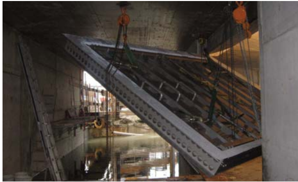
Einbringen des Drucktors durch die Öffnung in der Stollenwand.
