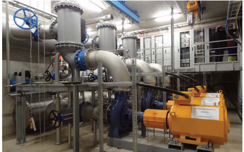
Pumpengruppe mit den Filtereinheiten.
