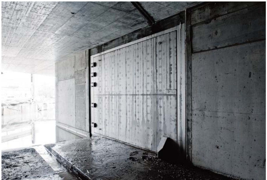
Das eingebaute, geschlossene Drucktor im Stollen.
