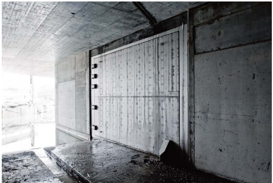
Porte étanche montée et fermée dans la galerie.
