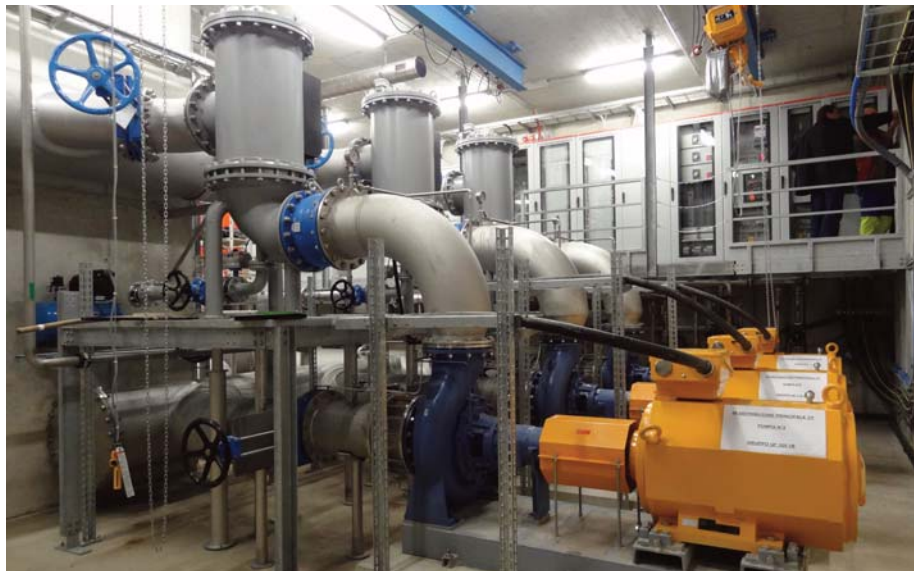
Groupe de pompes avec unité de filtres.
