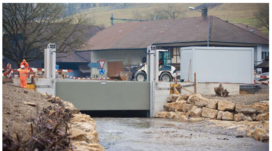
Vanne de réglage en position «hautes eaux». À droite, le container avec la commande, la télésurveillance, le groupe hydraulique et les accumulateurs.
