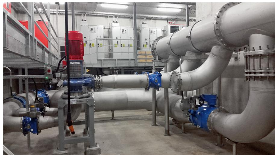
Tuyauterie ROMAG en acier inoxydable dans l'installation des turbines pour la production d'électricité.
