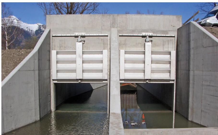
2 vannes hydrauliques (3.5 m x 2.0 m) du bassin de retenue contre les crues du Rhin.
