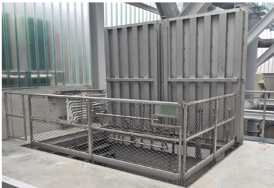
Couvercle de fosse avec garde-corps relevable et protection anti-chute intégrée conformes aux directives bpa et SUVA.
