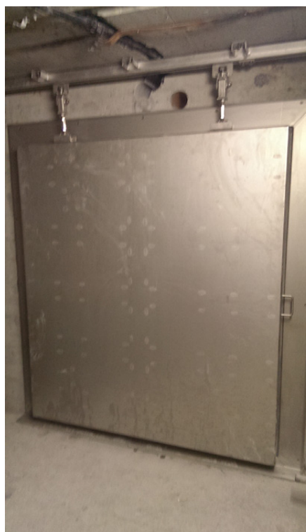
Cette porte étanche coulissante (1.7 x 1.9 m) du barrage de Mapragg au-dessus de Bad Ragaz protège le local technique qui pourrait être inondé en cas de crue exceptionnelle.
