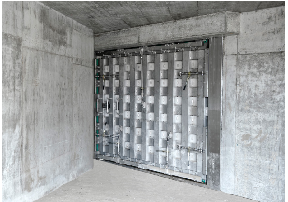
La porte étanche de la galerie de Lyssbach permet le passage des véhicules d'entretien.
