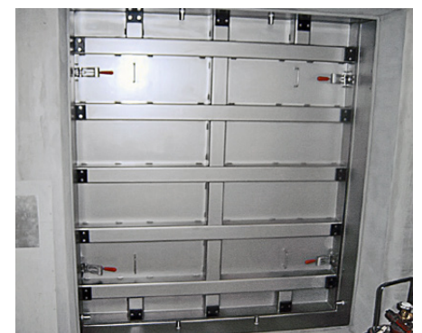
Cette porte étanche coulissante (1.7 x 1.9 m) du barrage de Mapragg au-dessus de Bad Ragaz protège le local technique qui pourrait être inondé en cas de crue exceptionnelle.
