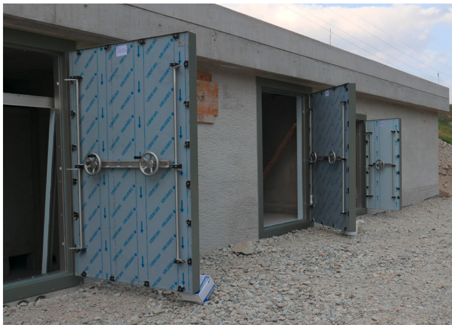
Ces portes étanches protègent l'usine électrique Füreli à Hinterrhein GR contre les avalanches.
