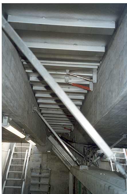
Neuhof Baar: Décharge de hautes eaux et canal tampon; Couvercles supportant le poids d'une personne avec barrière rabattable (petit couvercle de gauche).
