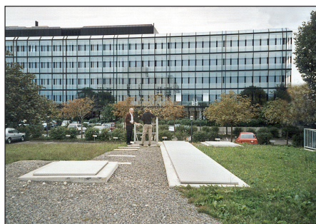
Neuhof Baar: Décharge de hautes eaux et canal tampon; Couvercles supportant le poids d'une personne avec barrière rabattable (petit couvercle de gauche).
