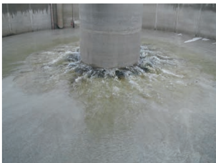
Spülung eines Rundbeckens
