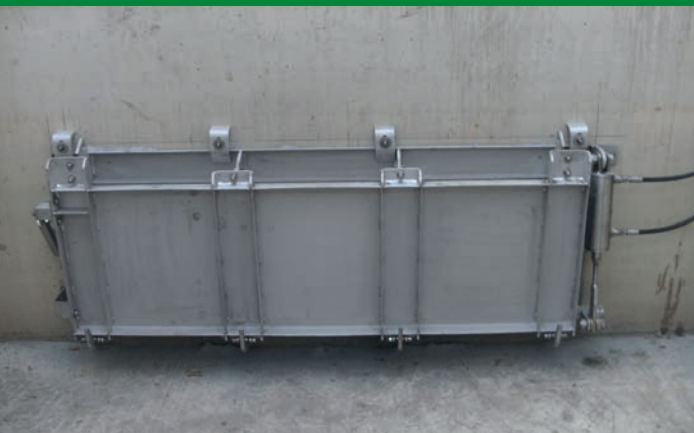
Einsatz einer Klappe im Regenbecken
