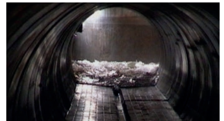
Spülung eines Stauraumkanals
