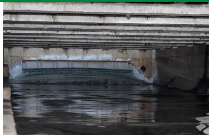
Einsatz einer Klappe im Regenbecken
