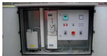
Steuereinheit Typ EGAR im Schutzschränk
