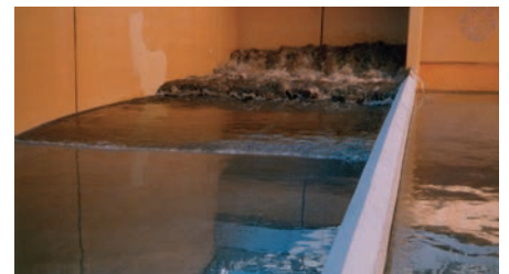
Spülung eines Rechteckbeckens
