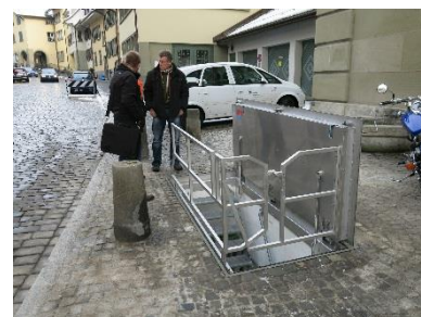
Berne : couvercle de regard du type S14, 2500 x 950 mm, balustrade automatique, isolée thermiquement
