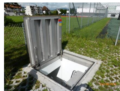
Couvercle de regard du type S14, 1000 x 1000 mm
