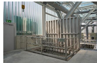
Berne : construction spéciale, couvercle de regard du type S14 en deux parties, 3600 x 2650 mm, balustrade manuelle avec WebNet
