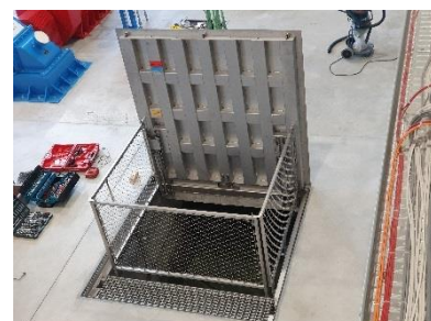
Schattdorf: Spezialkonstruktion, S14 Schachtabdeckung, 2000 x 2000 mm, Aufziehgeländer mit WebNet, Teilgitterrost
