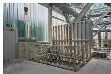
Bern: Spezialkonstruktion, S14 Schachtabdeckung zweiteilig, 3600 x 2650 mm, Aufziehgeländer mit WebNet
