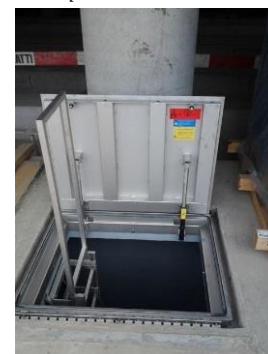
Couvercle de regard ROMAG du type S14L avec échelle d'accès
