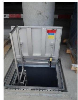
S14L Schachtabdeckung mit Aufstiegsleiter
