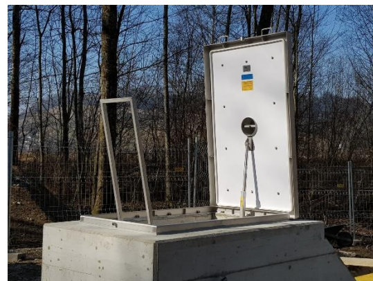
Couvercle de regard du type S2 avec aide à l'entrée et à la sortie
