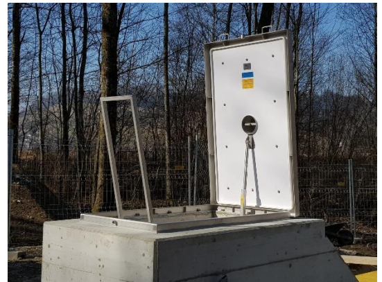
Schachtabdeckung Typ S2 mit ausziehbarer Leiterverlängerung
