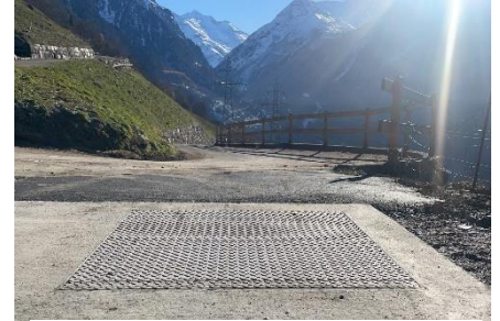
Le Rocher : couvercle de regard ROMAG du type S21, 1000 x 1000 mm
