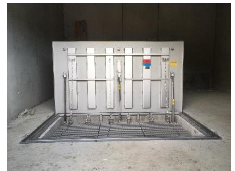
Schachtabdeckung ROMAG Typ S4b, mit WebNet Fallschutz
