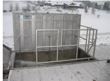
Schachtabdeckung ROMAG Typ S4a, mit Aufklappgeländer
