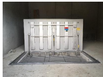
Couvercle de regard ROMAG du type S4b, avec protection antichute du type WebNet
