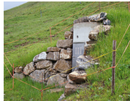
Zugang zur Brunnenstube – perfekt in die Landschaft eingebettet
