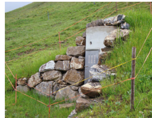
Accès à la chambre de captage : parfaitement intégré au paysage
