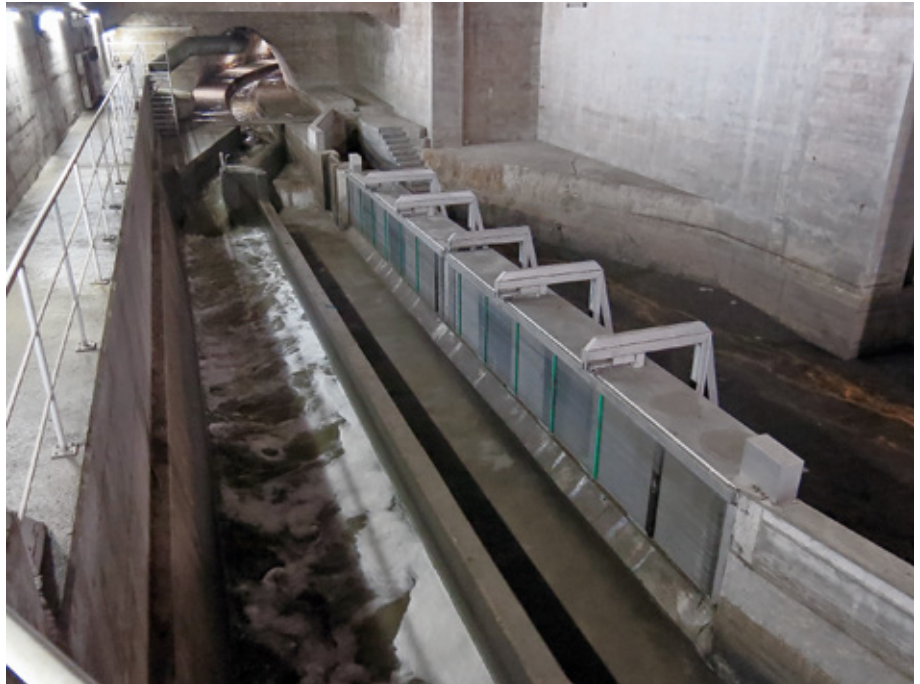
Vue dans l'ouvrage réalisé. En partie supérieure la galerie d'amenée
