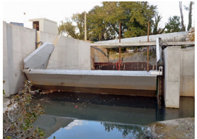
Im Canal de Champfleury eingebaute Regelklappe
