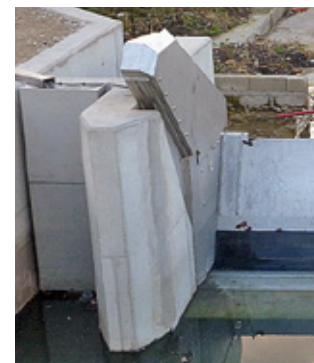
Im Zuflussbereich perfektes Zusammenspiel von Bauwerk und Einbauten
