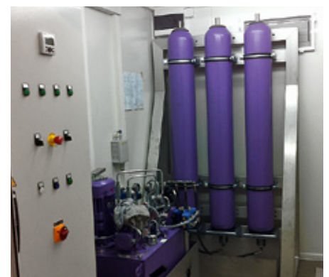
Hydraulikaggregat mit Druckspeicher und Steuerkasten im Container
