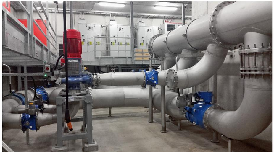
ROMAG-Edelstahlverrohrungen in der Turbinenanlage zur Elektrizitätsgewinnung.
