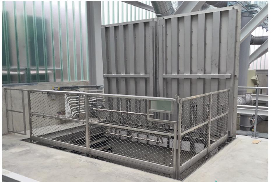
Schachtabdeckung mit aufklappbarem Geländer und integriertem Fallschutz entsprechend den BfU- und SUVA-Richtlinien.
