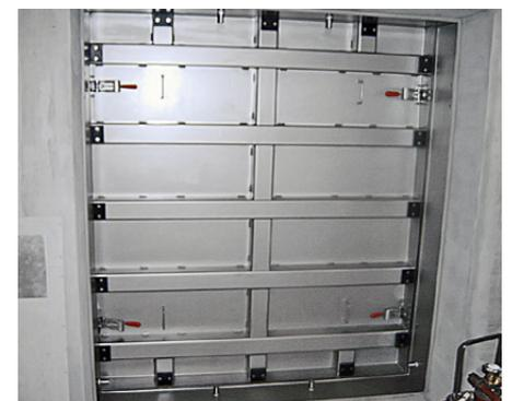
Diese Schiebedrucktüre (1.7 x 1.9 m) schützt den Technikraum beim Mapragg-Stausee ob Bad Ragaz, der bei einem ausserordentlichen Hochwasser überflutet werden könnte.
