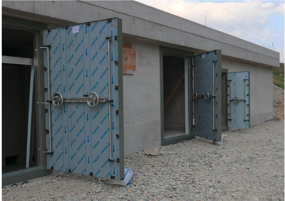
Diese Drucktüren schützen das Kraftwerk Fürreli in Hinterrhein/GR gegen Lawinen.
