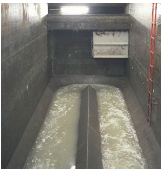
ARA Zürich-Wollishofen, rechte Beckenhälfte mit Siebgutschacht im Hintergrund. Der ROMAG-Siebrechen RSU ist hinter der Betonschwelle eingebaut.
