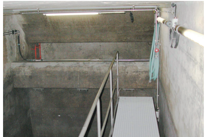
ARA Zürich-Wollishofen, Linke Beckenhälfte, ROMAG-Siebrechen RSU im Hintergrund. Die Hydraulikleitung für den Zylinder ist gut sichtbar. Der Hydraulikzylinder ist oberhalb der Mauerkante knapp sichtbar.
