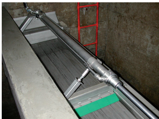
ROMAG-Siebrechen RSU. Entlastungsseite mit Hydraulikzylinder und Reinigungswagen. Betonschwelle bildet Notentlastung.
